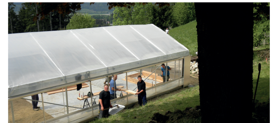
Bau des Gewächshauses (2011)
